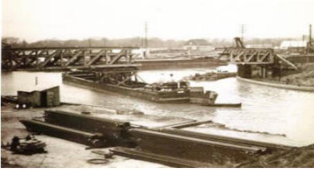
*Démontage de la passerelle de halage devenue inutile suite à l'arrêt de la traction sur berge en 1970*
