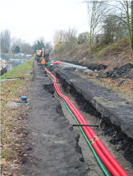
*passage des réseaux (eau, électricité, éclairage public et installation de bornes pour les bateliers et les plaisanciers)*
