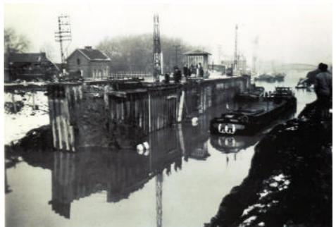
*Enlèvement des maçonneries du radier et de l'avant radier*
